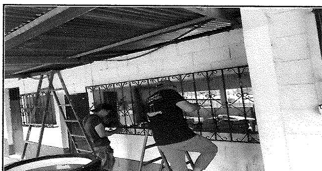
Foto 6: Reparación de balcones.
