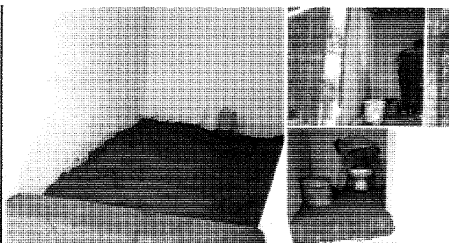
Foto 9: Sustitución de inodoros.
